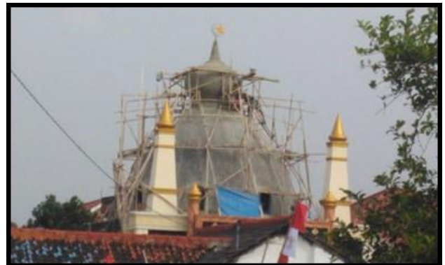
Gambar 53. Pemlesteran permukaan kubah
