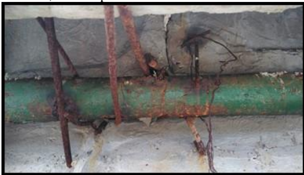
Gambar 2. Korosi pada kerangka pipa baja penopang kubah GRC
