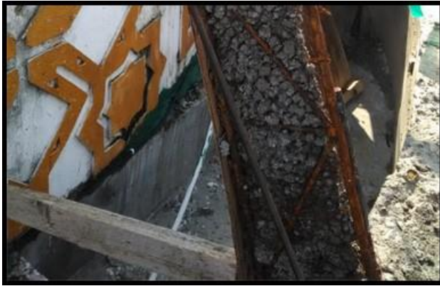
Gambar 9. Pemlesteran rib kubah dengan mortar
