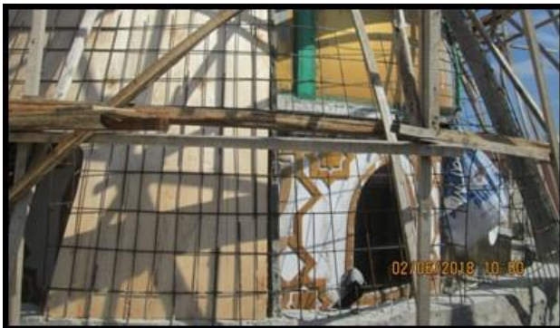
Gambar 20. Pemasangan tulangan utama kubah
