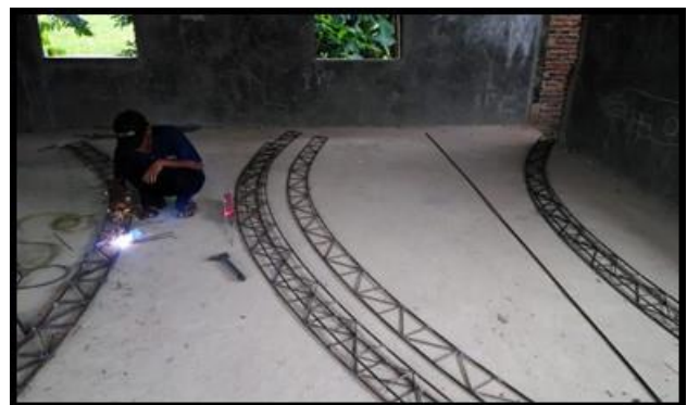
Gambar 8. Pembuatan kerangka rib kubah
