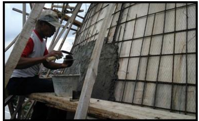
Gambar 4. Pemlesteran kubah dengan mortar
