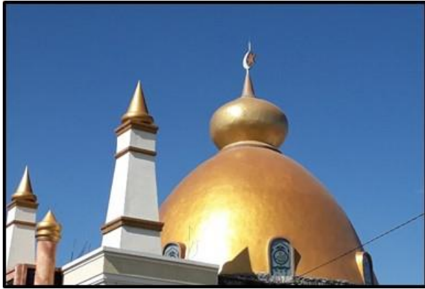
Gambar 14. Kubah ferosemen terpasang
