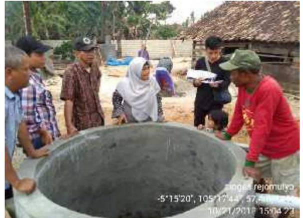
Gambar 7. Lubang digester yang sudah diplester
