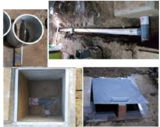
Gambar 5. Pengaturan aliran air dari WC yang dilengkapi dengan bak kontrol.
