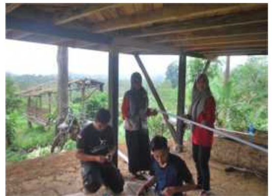
Gambar 9. Persiapan pendistribusian air menggunakan pipa paralon
