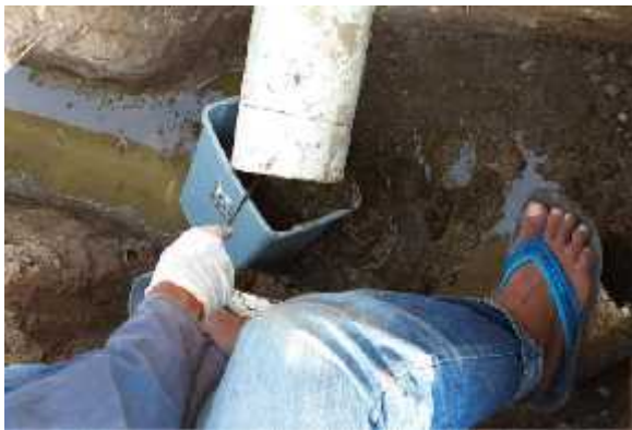
Gambar 4. Pembersihan saluran dari WC
