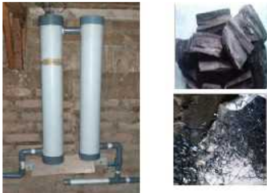
Gambar 8. Tabung filter biogas yang berisi arang dan geram besi
