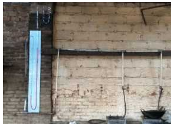
Gambar 6 Pemasangan manometer U
