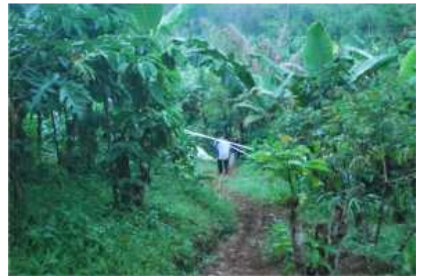
Gambar 10. Persiapan pemasangan pipa oleh tim
