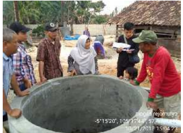
Gambar 7. Lubang digester yang sudah diplester
