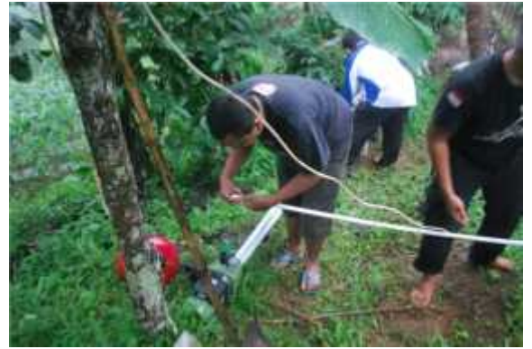
Gambar 8. Instalasi pompa air
