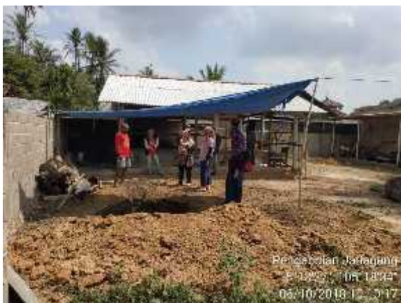
Gambar 6. Pembuatan lubang digester
