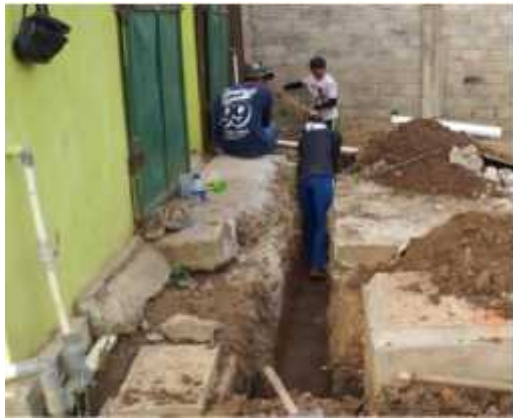
Gambar 3. Penggalian saluran untuk pipa
