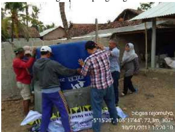
Gambar 10. Tanki air dimasukkan ke dalam lubang digester dengan posisi terbalik
