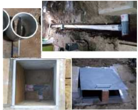
Gambar 5. Pengaturan aliran air dari WC yang dilengkapi dengan bak kontrol.
