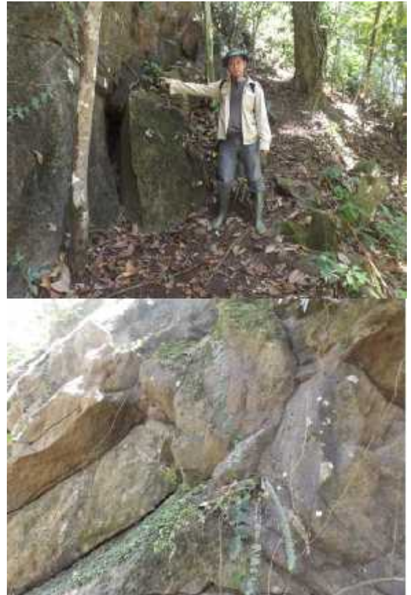
Gambar 3. Potensi ketidakstabilan lereng akibat slope dan kekar gerus yang perlu diwaspadai di lokasi air terjun Air Naningan Way Harong.
