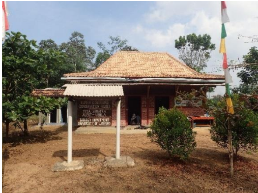
Figure 2. Rumah Konservasi Jurusan Biologi Universitas Lampung, Margahayu, Labuhan Ratu VII
